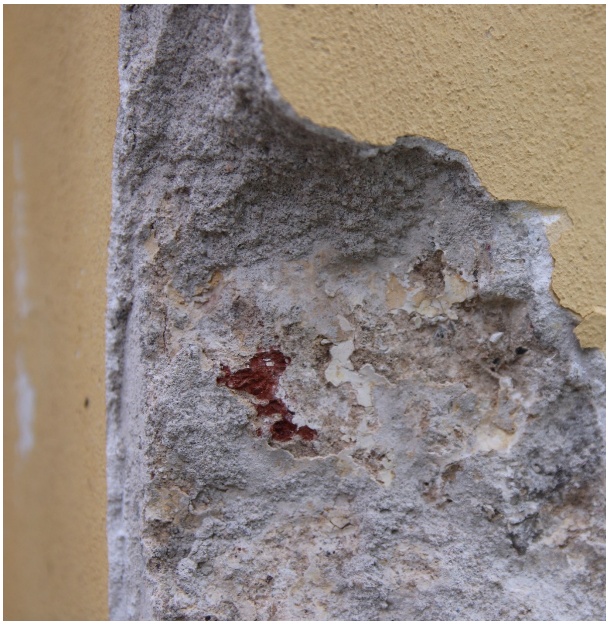
Sonda na vnitřní straně levého pilíře - na cihelném zdivu vyskytují poměrně hluboko fragmenty značně nerovných omítek s několika vrstvami vápenných líček v bílém a okrovém odstínu
