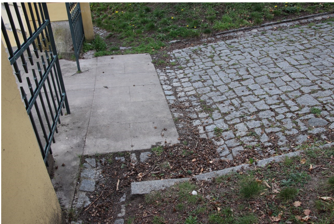
Pohled na napojení na cestu k záměčku (nedostatečně řešený odvod vody, který má za následek destrukci stavebních konstrukcí pod schodištěm)
