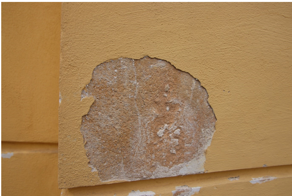
Nález probarvené štukové vrstvy na bose pravého pilíře
