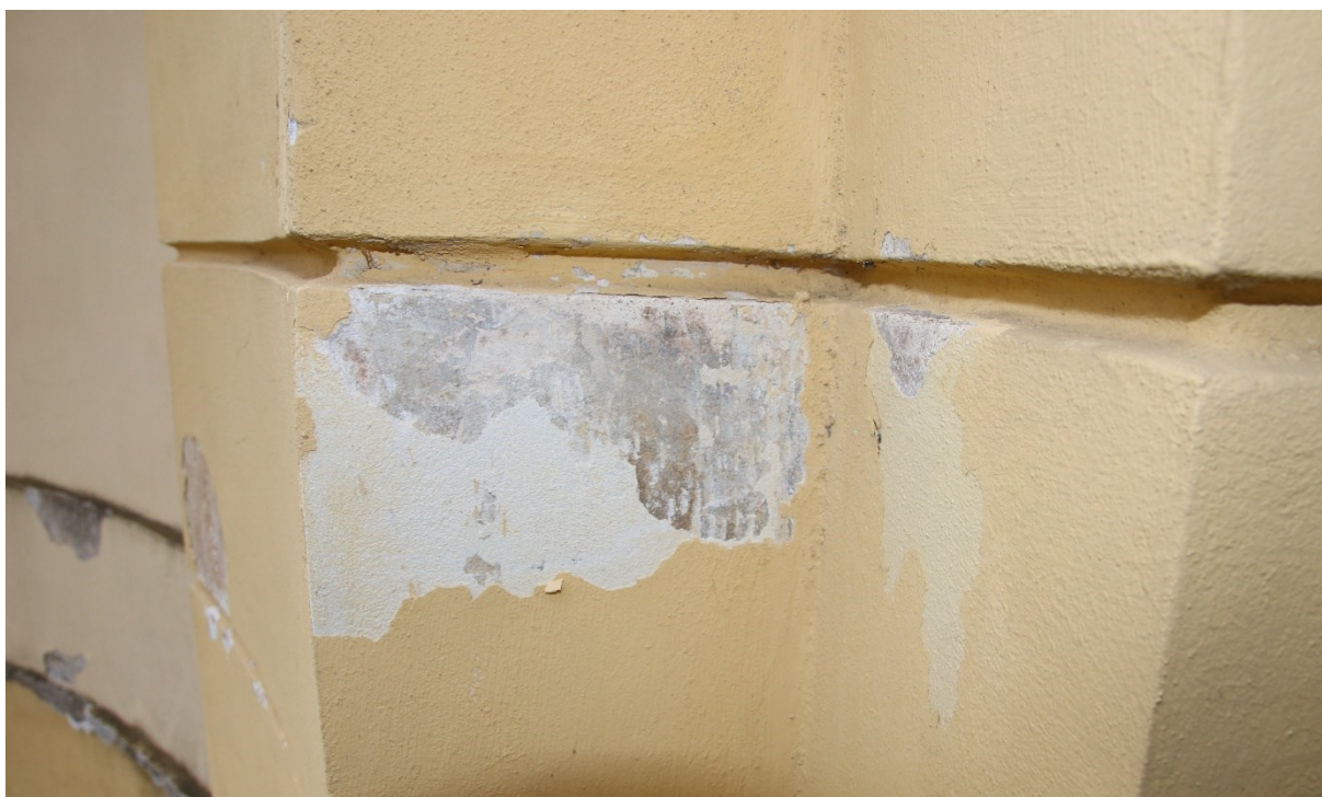
Nálezy nátěrů na bosování levého pilíře (ve spodní úrovni utahovaná štuková probarvená vrstva, na ní vrstvy vápenných nátěrů v okrových odstínech, dále štuková novodobá vrstva se stávajícím minerálním (?) nátěrem na povrchu)
