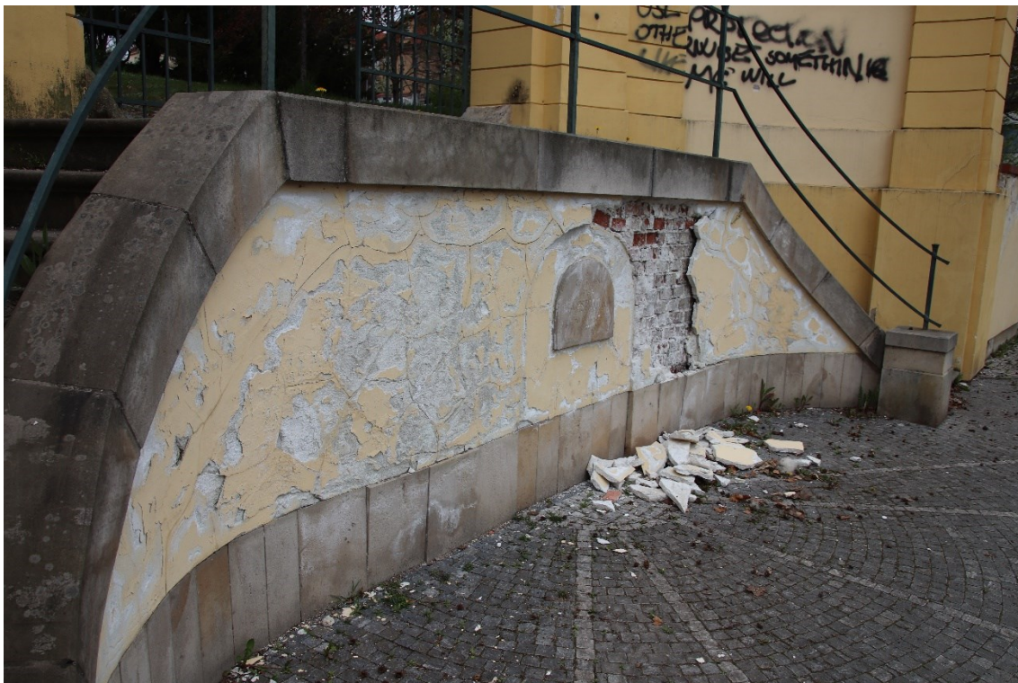
Pohled na destrukci omítek a cihelného zdiva pod schodištěm (následek dlouhodobého zatékání z horní úrovně parku)
